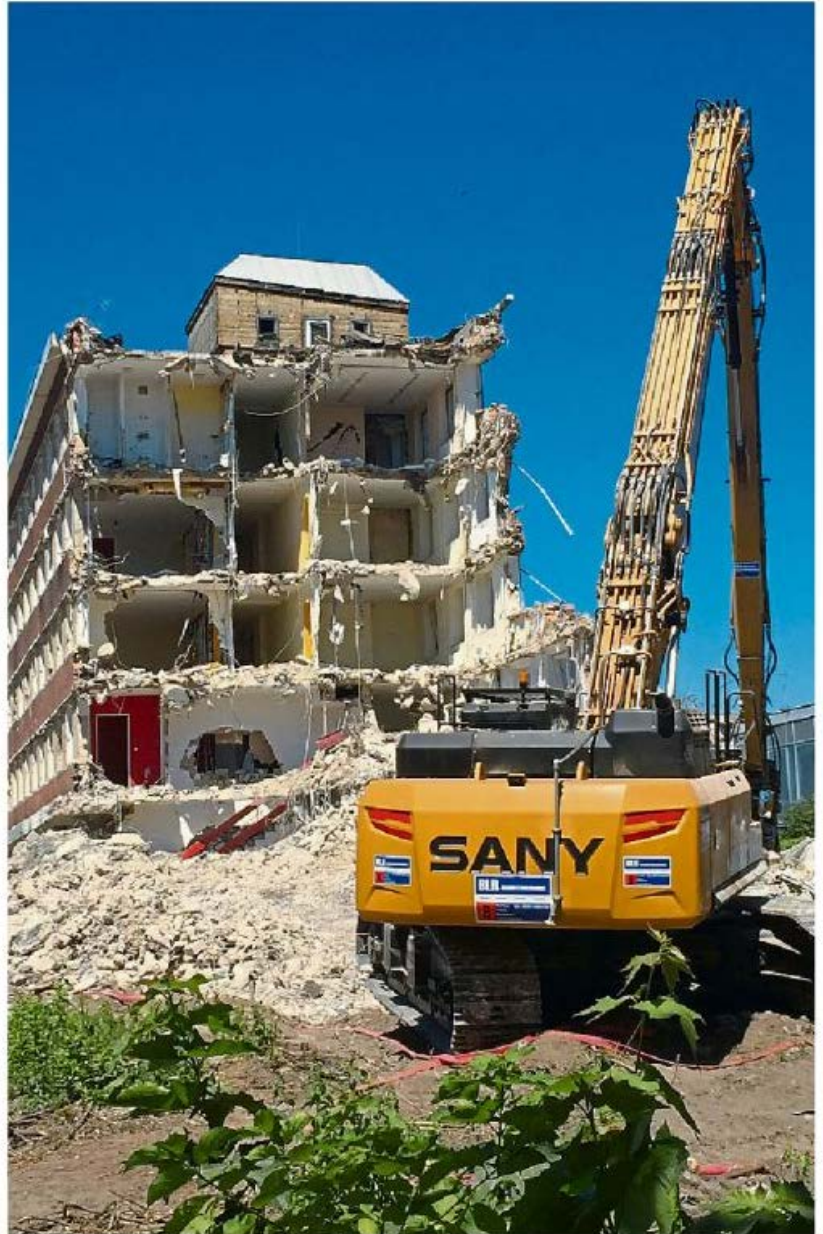
Das Ludgerushaus in Nachbarschaft des Overberg-Kollegs an der Fliednerstraße wird derzeit abgerissen. Hier baut das Bistum ein neues Wohnheim für Studierende.
