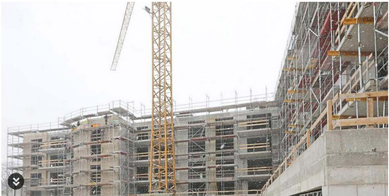
Der Rohbau der Studentenwohnungen und die Erweiterung des Tagungshotels des DRK-Landesverbandes sind fertig. Demnächst ist Richtfest. Foto: Matthias Ahlke
