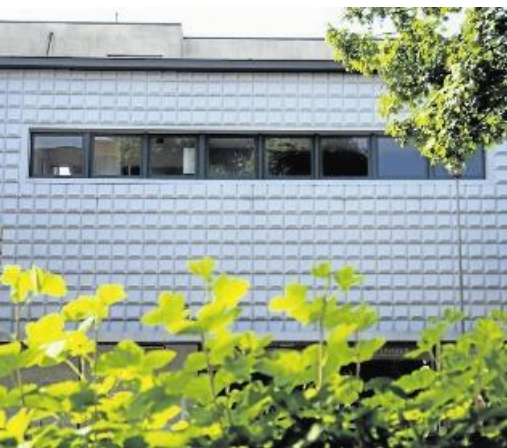
Im Oktober könnte das ehemalige Kaufhaus Magnus abgerissen werden. GZ-Foto Haged
